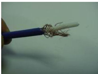
2- Togliere la guaina esterna con un cutter e scoprire la calza di metallo.
